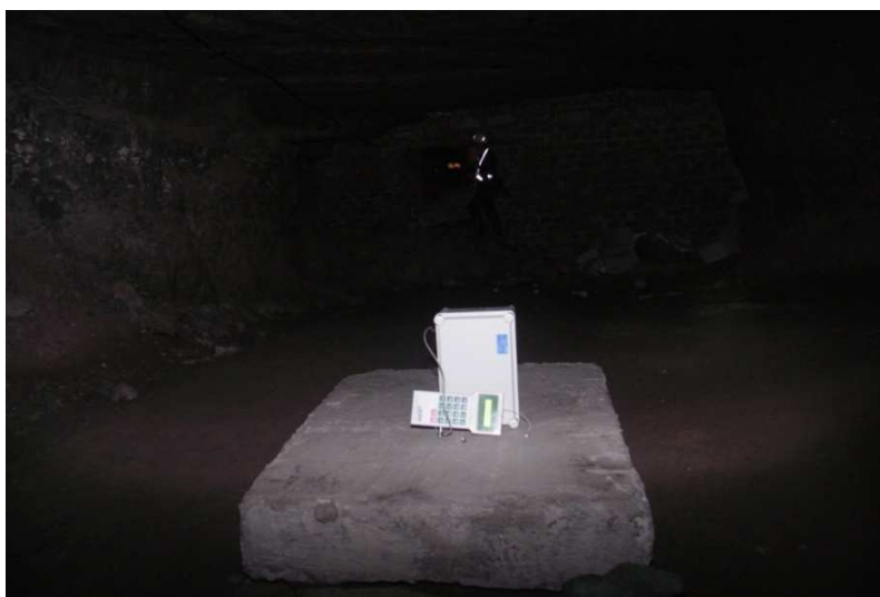
Fot. 5.1. Miejsce pomiarowe ciśnienia powietrza kopalnianego (na rys.5.8 oznaczone 1), w tle widoczna osoba dokonująca pomiaru wartości prędkości powietrza w oknie regulacyjnym (4) tamy murowej (3)
