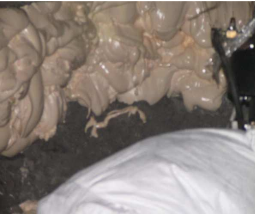
Fot. 5.4. Doszczelnienie tam środkiem ekoflex
