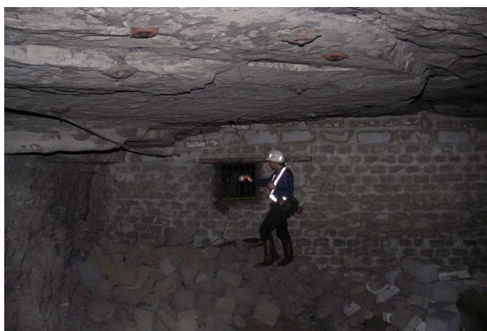
Fot. 5.2. Pomiar wartości prędkości przepływu powietrza w oknie regulacyjnym (4) w tamie murowej (3)
