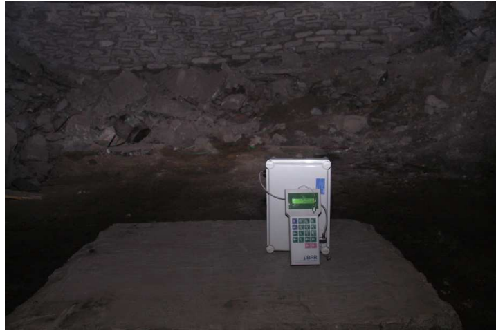
Fot. 5.3. Pomiar wartości ciśnienia powietrza kopalnianego w miejscu pomiarowym (2), w tle widoczna tama murowa na urobku – na rys.5.8 oznaczona (5)
