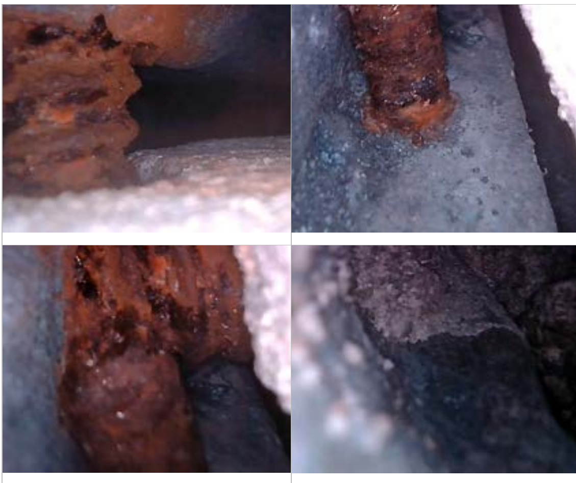
Rys. 9.27. Obrazy zarejestrowane z wykorzystaniem kamery endoskopowej przedstawiające wnętrze nagrobka i elementy konstrukcyjne [Fot. A. Garbacz-Klempka]
