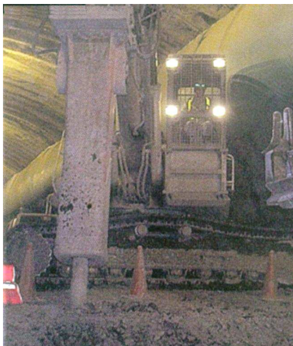
Rys. 2.14. Zastosowanie młota hydraulicznego zamocowanego na wysięgniku zainstalowanym na podwoziu gąsienicowym do wykonywania wykopu w spągu wyrobiska [22]
