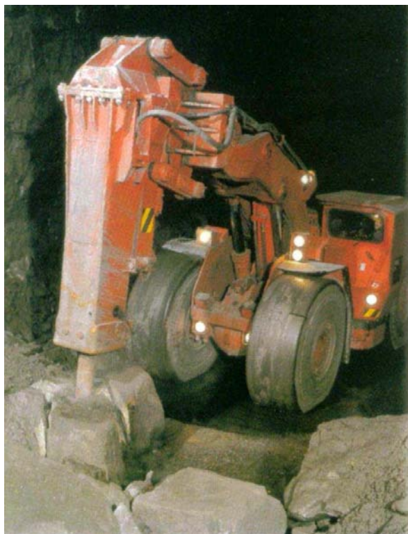
Rys. 2.11. Widok młota hydraulicznego na wysięgniku ładowarki TORO, wykorzystywanego do rozbijania brył w przodku [22]
