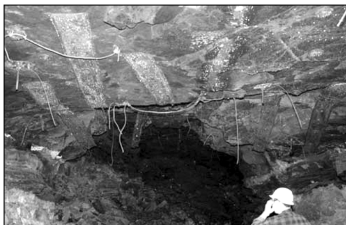
Rys. 3. Dojście do przodka pasa P-73a
