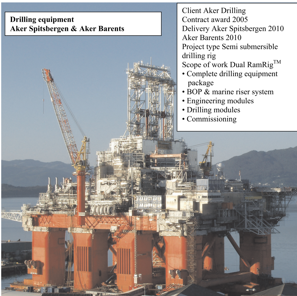
Rys. 5. Nowoczesna platforma wiertnicza z podwójnym hydraulicznym masztem typu Dual RamRig™ przeznaczona do wierceń przy dużych głębokościach wody [10]
