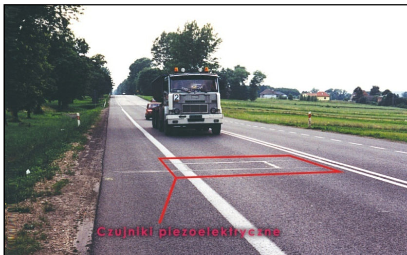
Rys. 2.7. System HS-WIM z czujnikami piezoelektrycznymi
