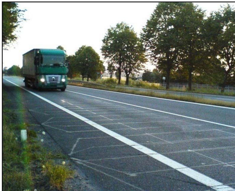
Rys. 2.8. System MS-WIM z czujnikami polimerowymi
