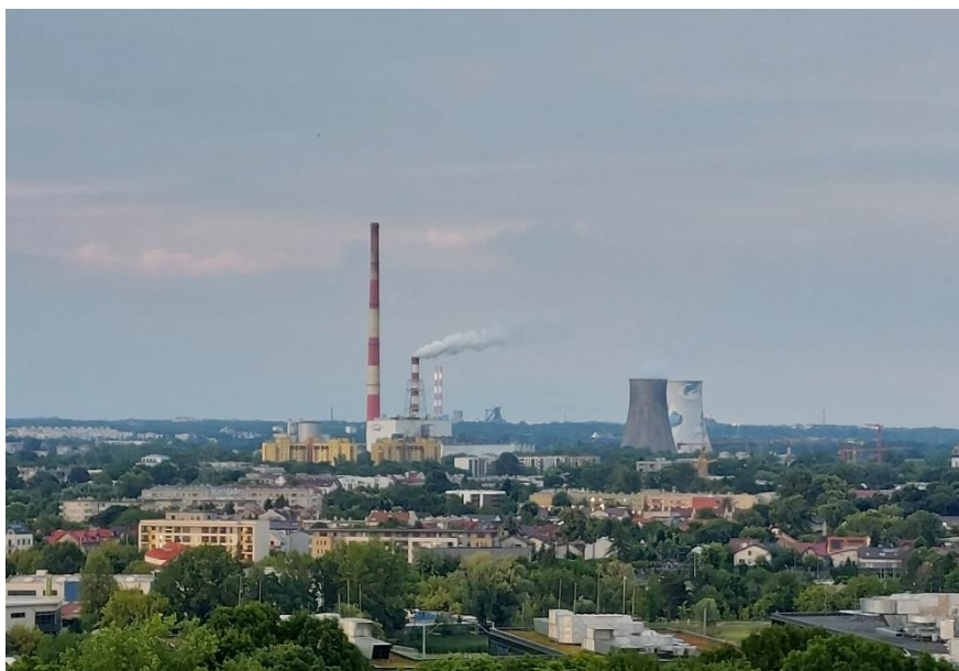
Rys. 30. Elektrociepłownia Kraków Źródło: własne
