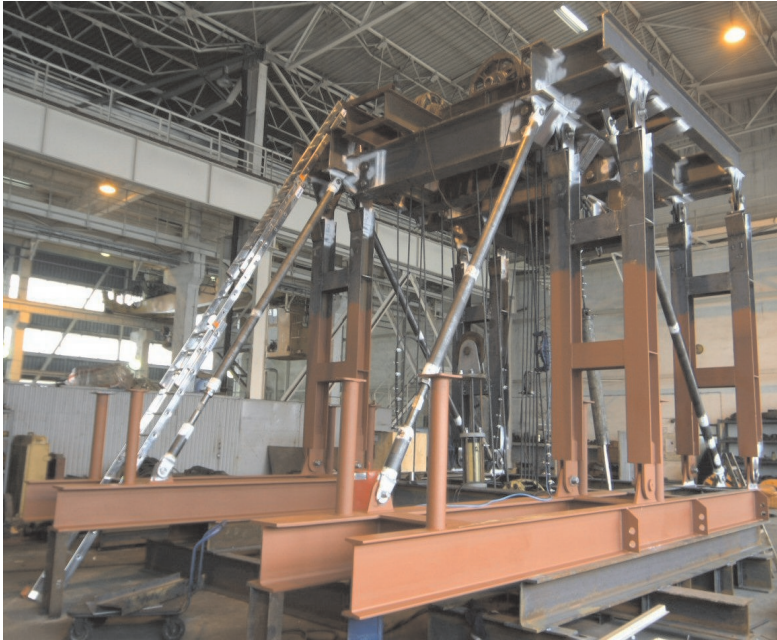
Rys. 8. Podbudowa urządzenia Skytop Brewster TR 800 przygotowana do próby obciążeniowej
