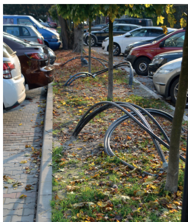
Rys. 10. Rozmieszczenie otworowych wymienników ciepła na polu B Laboratorium Geoenergetyki wierconych ukośnie (kąt początkowy do 13° w stosunku do pionu) (fot. Tomasz Śliwa)
