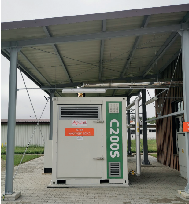
Rys. 5. Turbina o mocy 200 kW zasilania biogazem
