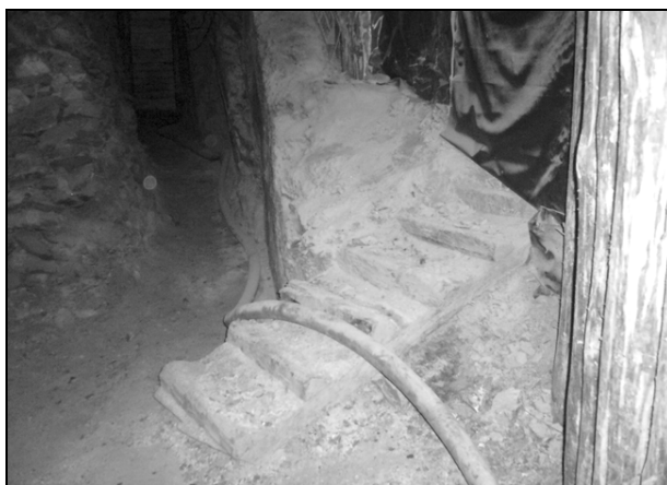
Rys. 8. Odsłonięty podczas prac zabezpieczających fragment schodów w poprzeczniku Reichtzer V
