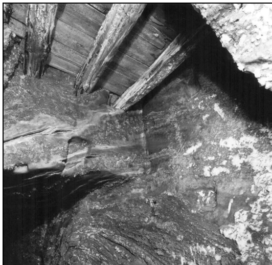
Rys. 3. Podłużnia Sobieski w rejonie szybiku Jana Kazimierza — przed wykonaniem prac rewaloryzacyjnych
