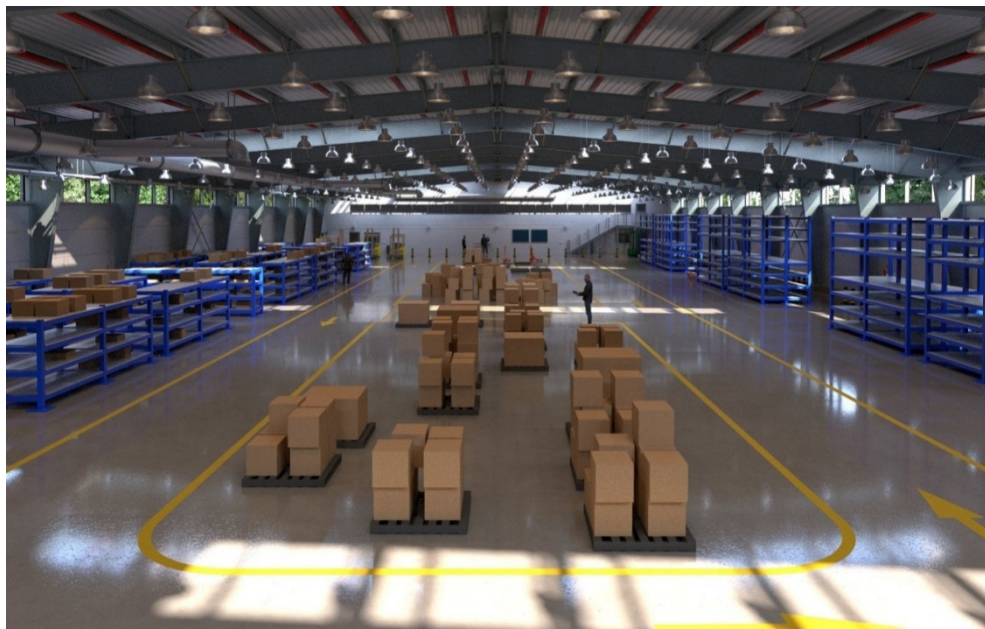
Rys. 19. Wnętrze budynku – część produkcyjno-magazynowa
