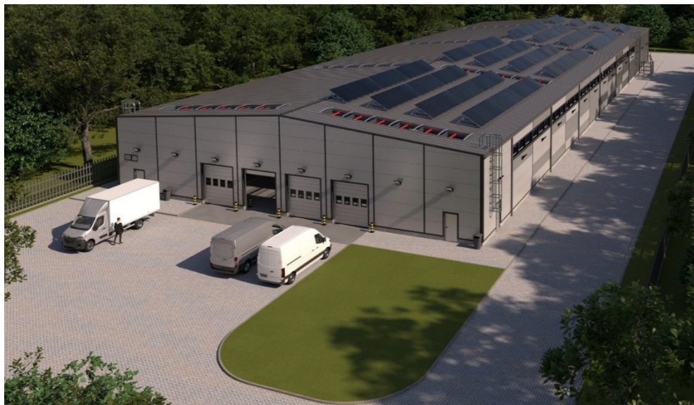
Rys. 18. Zewnętrzna część budynku od strony placu załadunkowego
