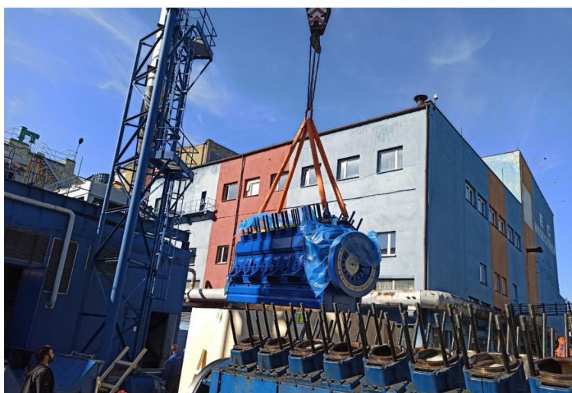
Rys. 82 Remont E-70 montaż nowego „short blocku”.
