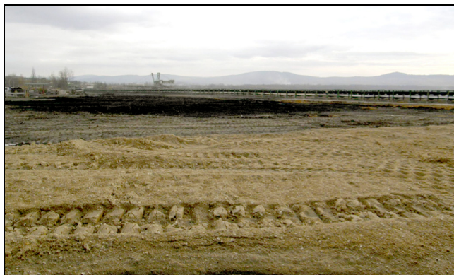
Rys. 4. Zasypana wyrwa i odbudowany ciąg ON-1
