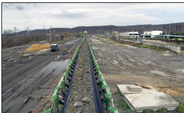
Rys. 6. Zasypana wyrwa i odbudowany ciąg ON-3
