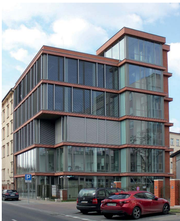
Rys. 1. Budynek Małopolskiego Laboratorium Budownictwa Energooszczędnego Politechniki Krakowskiej
