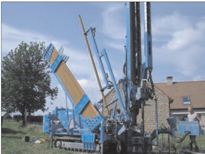
Rys. 4. Automatyczny podajnik rur płuczkowych wiertnicy Comacchio
