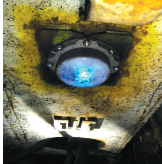
Rys. 8. Montaż czujnika w warunkach rzeczywistych z wykorzystaniem uchwytów
