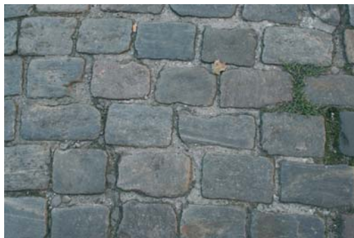
Fig. 12. Nawierzchnia jezdni z gnejsowej kostki na krakowskim Kazimierzu
