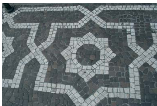
Fig. 7. Mozaika z drobnej kostki z porfiru z Miękini i marmuru „Biała Marianna” ze Stronia Śląskiego na chodniku ul. Szpitalnej
