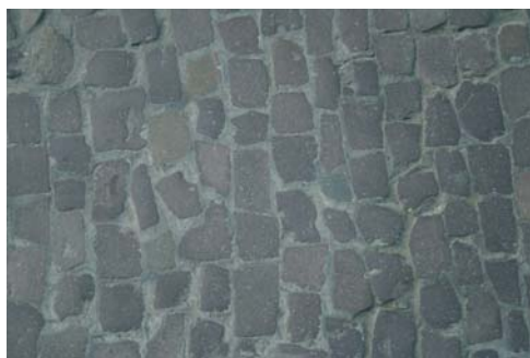
Fig. 5. Chodnik z porfirowych pieńków na ul. Mikołajskiej
