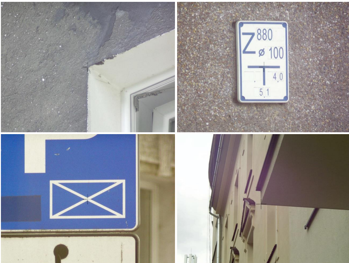
Rysunek 32. Przykładowe fotopunkty - kolejno: przecięcie szańca, tabliczka orientacyjna, element znaku drogowego, element elewacji
