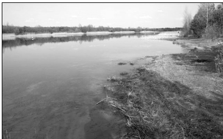
Rys. 3. Zbiornik w wyrobisku końcowym O/Bogdałów o powierzchni 11 ha i kubaturze 600 \text{ tys. m}^3 z przeznaczeniem do czerpania wody do celów p. pożarowych
