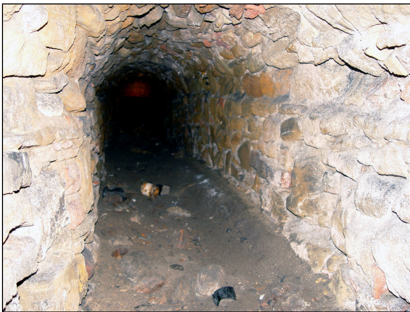
Rys. 1. Zabytkowy kolektor sanitarny (fot.: J. Chmura)
