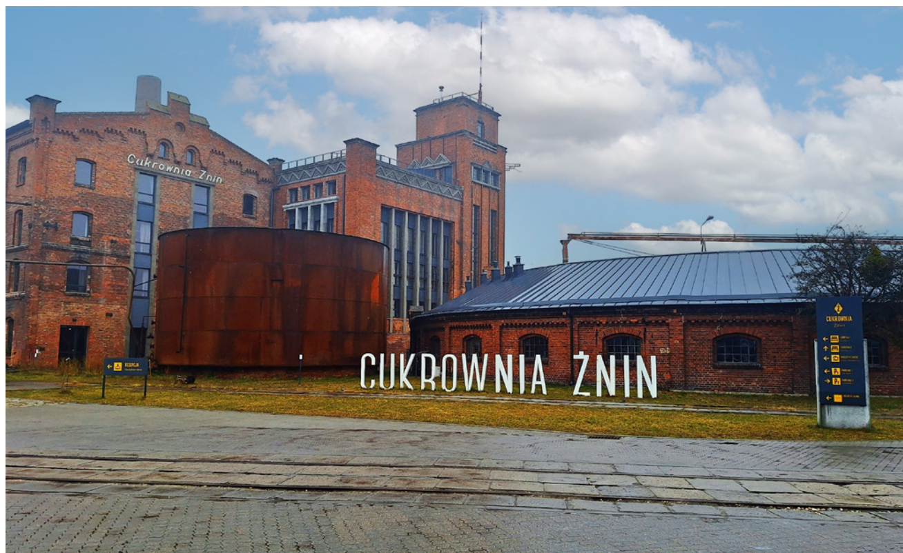
Cukrownia Żnin, fot. A. Ostręga
