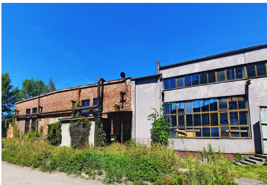
Stacja sprężarek i wentylatorów w roku 2021, fot. A. Ostrega
