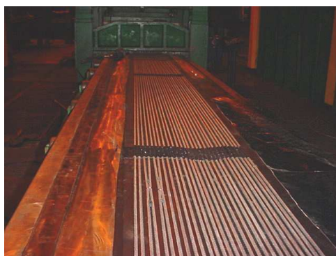
Rys. 8.24. Widok ułożenia linek na stole montażowym
