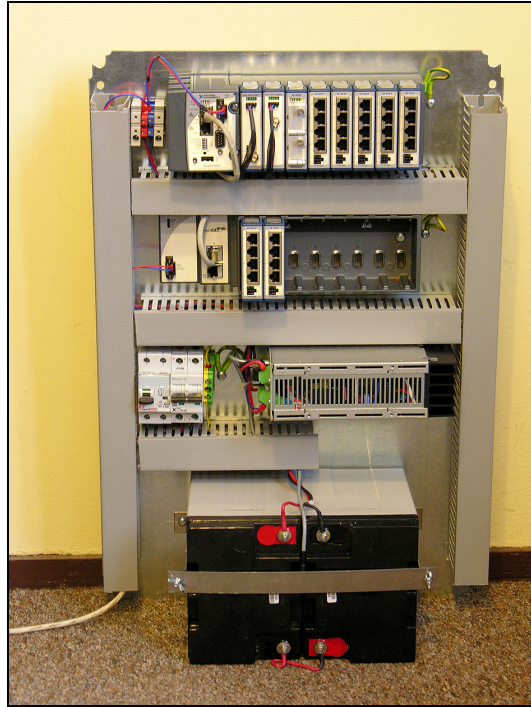
Rys. 3. Skrzynka sterownicza z zamontowanymi modułami systemu ciągłego monitoringu stanu wytężenia ustrojów nośnych maszyn podstawowych górnictwa odkrywkowego
