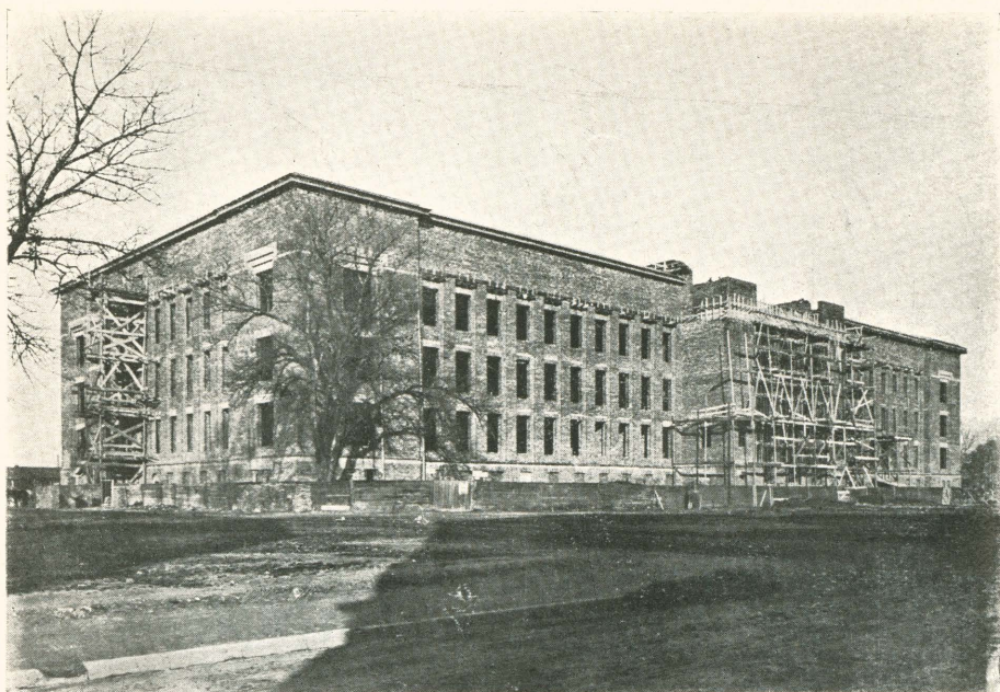
Budujący się gmach Akademii Górniczej. L'édifice de l'Académie des Mines en construction. The Mining Academy in building.
