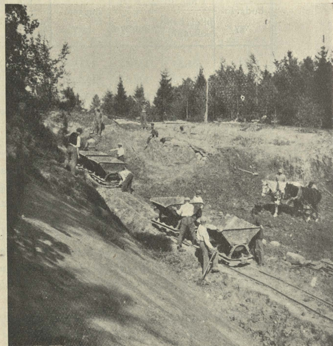
Głębokie wykopy przy budowie dróg.
