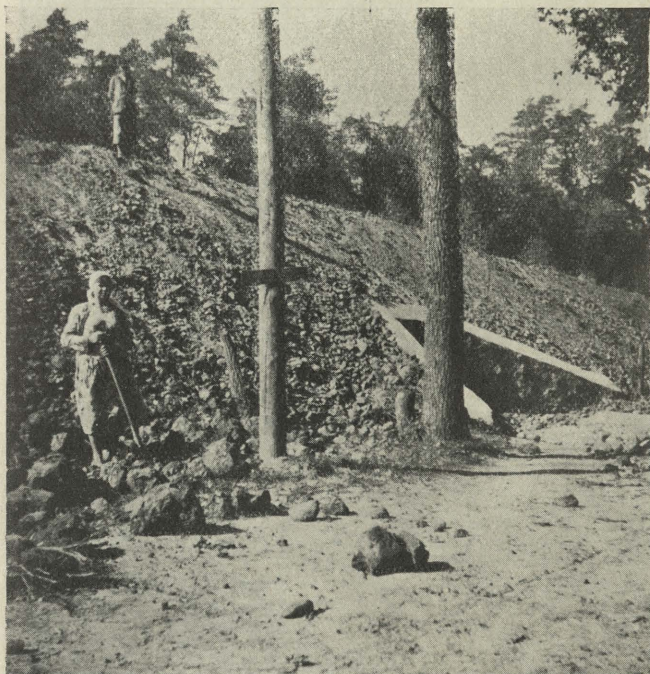
Roboty ziemne — nasypy 5 m.
