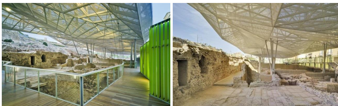
Rys. 2.19. Park archeologiczny El Molinete w Kartaginie (Hiszpania), chroniony przezroczystym dachem wykonanym m.in. z blachy perforowanej [N185]
