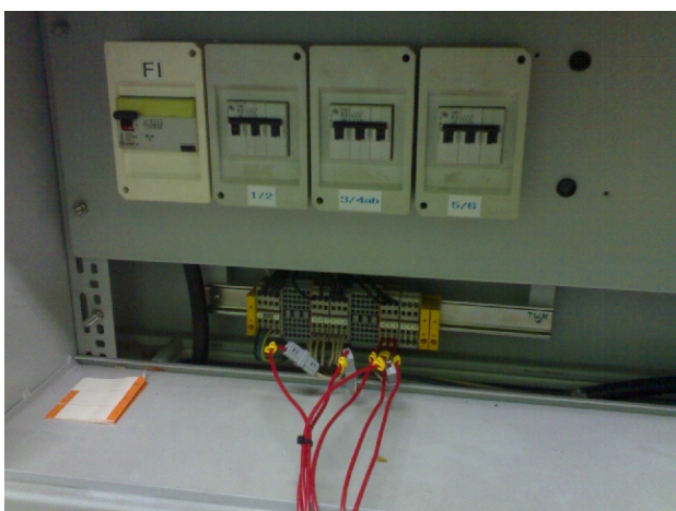
Rys. 86. Podłączenie modułu pomiarowego w nastawni stacji Kobiór
