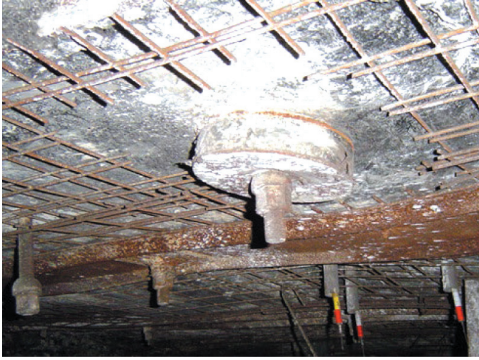
Rys. 4.26. Krążek dynamometryczny do pomiaru obciążeń kotw:
