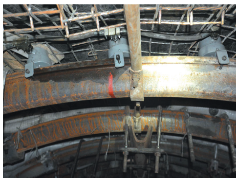
Rys. 4.6. Dynamometr szeregowy zabudowany w stropie wyrobiska
