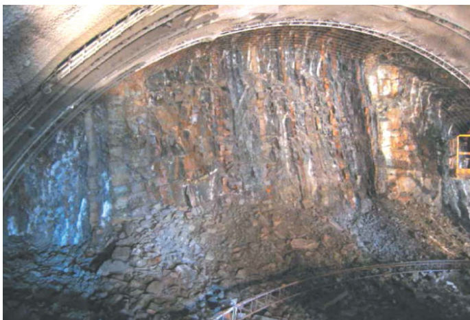
Rys. 3.30. Kalota w trakcie drążenia tunelu – 50,0 mb
