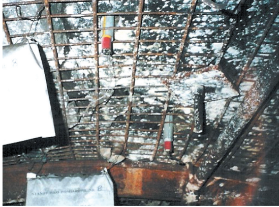
Rys. 3.60. Rozwarstwiomierze linkowe zabudowane w stropie wyrobiska
