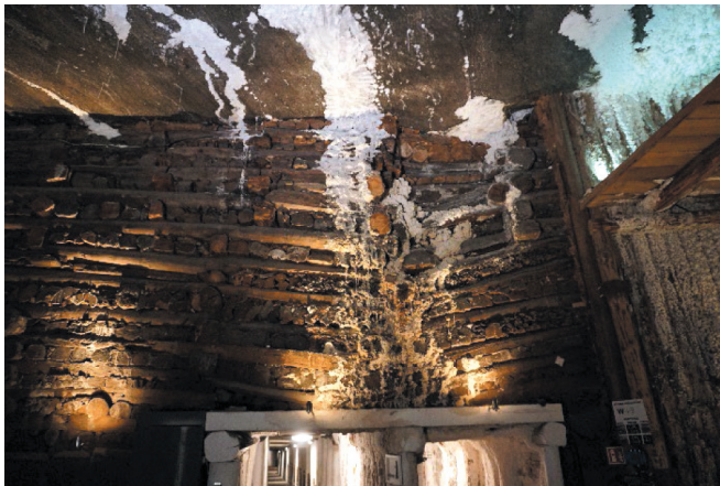
Rys. 3.44. Zaciskanie kasztów drewnianych i oblewanie ich solą w wyniku konwergencji komory – KS Wieliczka
