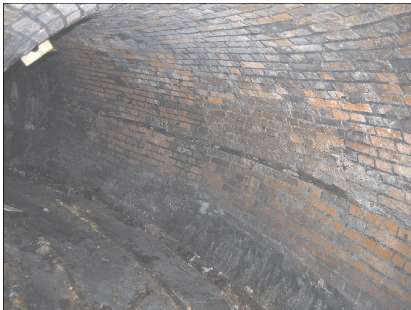
Rys. 1. Fragment bunkra popiołowego (fot. J. Przybyło)
