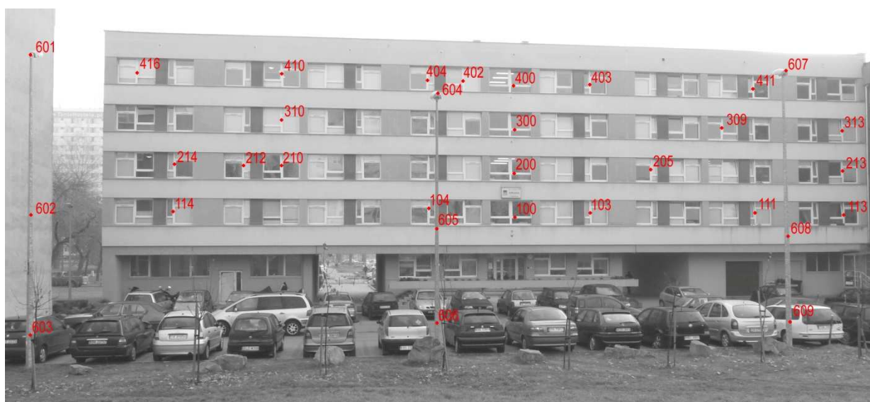
Rys. 22 Rozmieszczenie punktów kontrolowanych na polu testowym „Arkadia”
