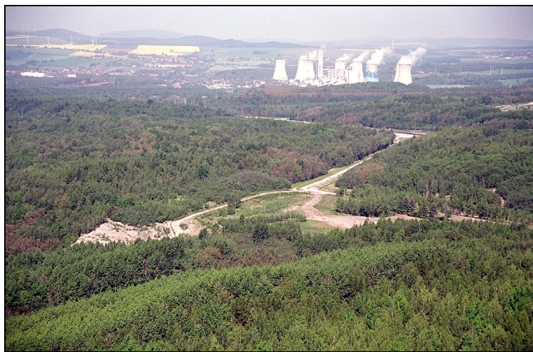
Rys. 5. Panorama zwałowiska zewnętrznego (Fot. KWB „Turów”)
