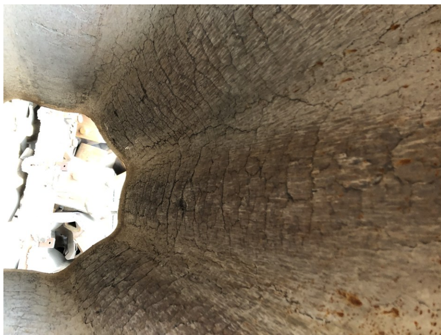
Rysunek 2.6 Siatka pęknięć na powierzchni wewnętrznej wlewnicy kuziennej
