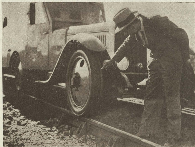
Koło pneumatyczne wagonu motorowego Michelin z widocznym pierścieniem, zabezpieczającym od zsunienia się opony z szyn.
