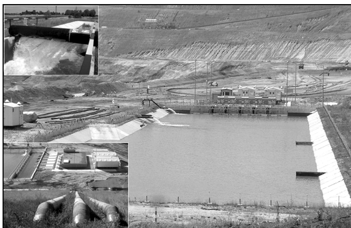
Rys. 15. Pompownia z pompami zatapialnymi OZ-400W [6]
