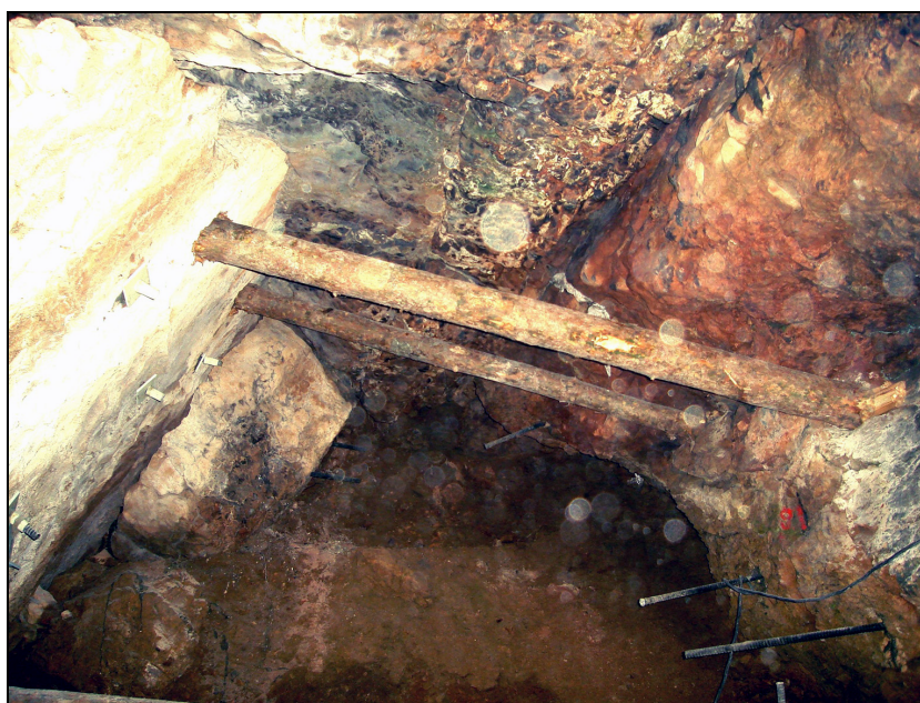
Rys. 4. Wnętrze jaskini w czasie prac zabezpieczających (fot.: J. Chmura)
