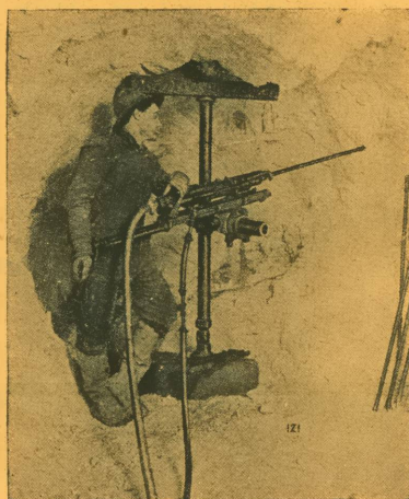
Mode d'emploi de la Perforatrice „Clipper“ modèle 50 équipée pour le travail sur support
