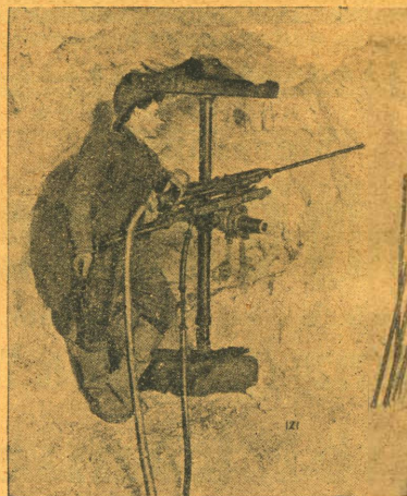
Sposób użycia perforatora (przedziurawiacza) „Clipper“ wzór 50, przystosowanego do pracy na podpórcie
