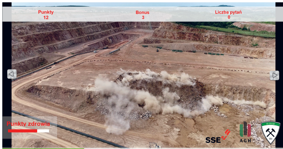
Rys. 1. Nagranie z drona wyświetlające się w trakcie ostatniego etapu szkolenia (odstrzału), prezentujące wygląd detonacji poprawnie zaprojektowanych i wykonanych robót strzałowych
