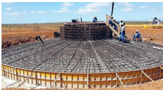
Rys. 5. Fundament bezpośredni monolityczny żelbetowy
