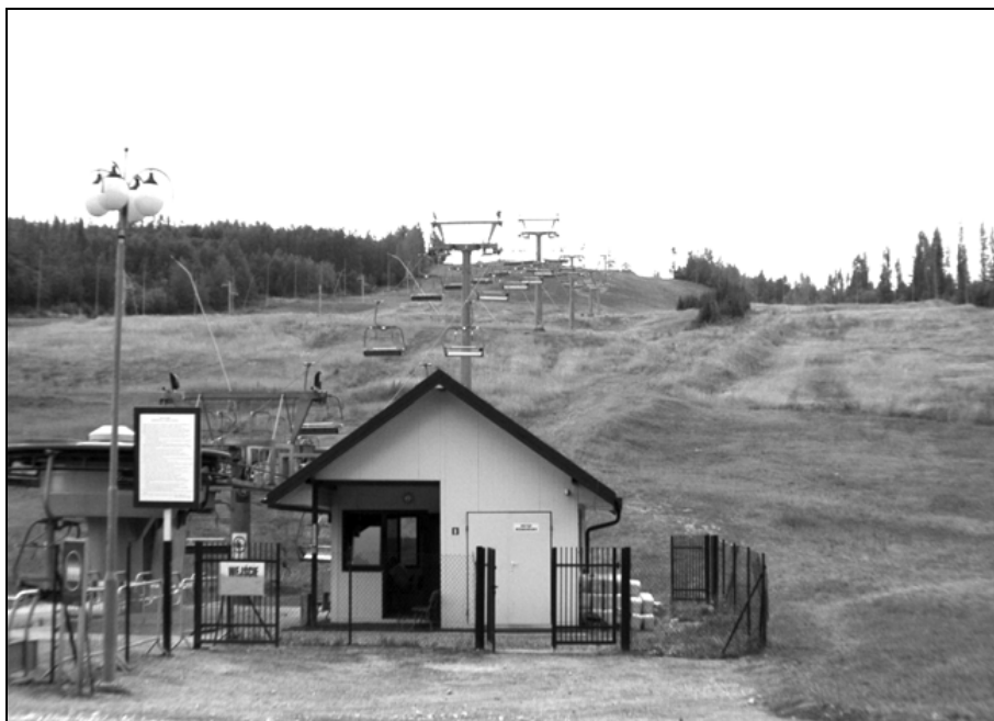
Rys. 4. Wyciąg narciarski na Górze Kamięńsk — stacja dolna
