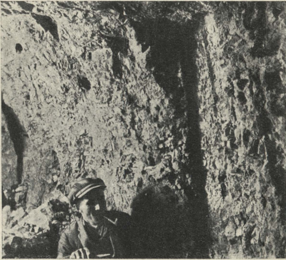
Fig. 135. Wycięta brózda. Usunięte zaokrąglenie stropu.
