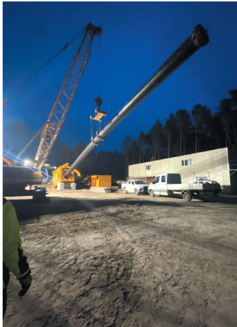
Rys. 23. Początek (a) i koniec (b) procesu instalacji rury osłonowej pod kable energetyczne w projekcie Baltic Power (fot. J. Janicki, 2024)
