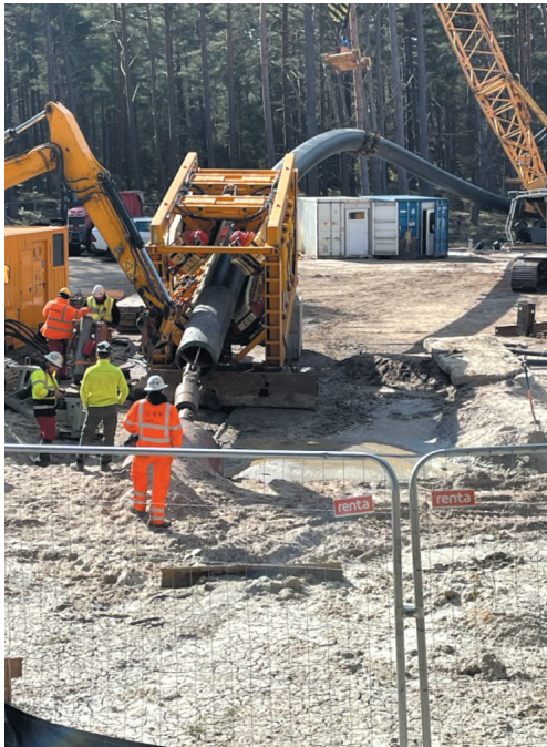
Rys. 23. Początek (a) i koniec (b) procesu instalacji rury osłonowej pod kable energetyczne w projekcie Baltic Power (fot. J. Janicki, 2024)
