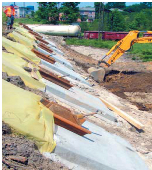
Rys. 8. Bloki kotwiące na płytach drogowych (fot. A. Jaroń)
