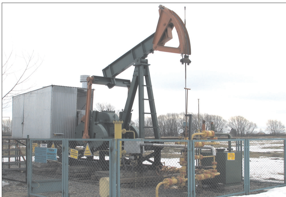
Rys. 5. Żuraw pompowy i urządzenia technologiczne przy odwiercie Terliczka 4
