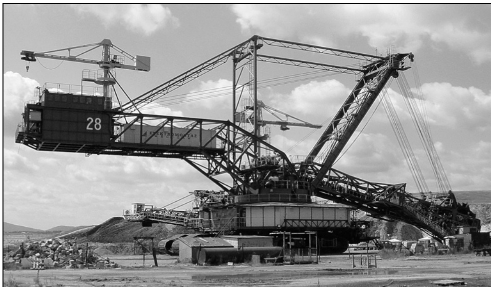
Rys. 1. Widok koparki wieloczepakowej kołowej
