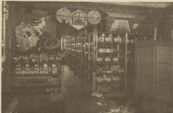
Magazyny części zapasowych.
