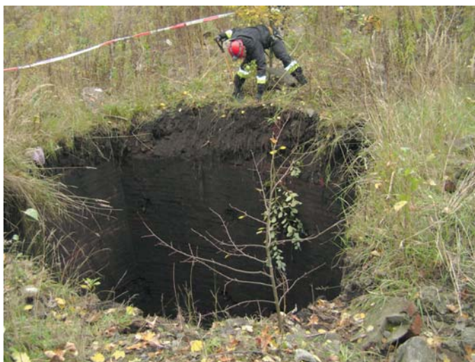
Fig. 1. Zapadlisko odsłaniające szyb wentylacyjny nr III, KWK „Matylda”
