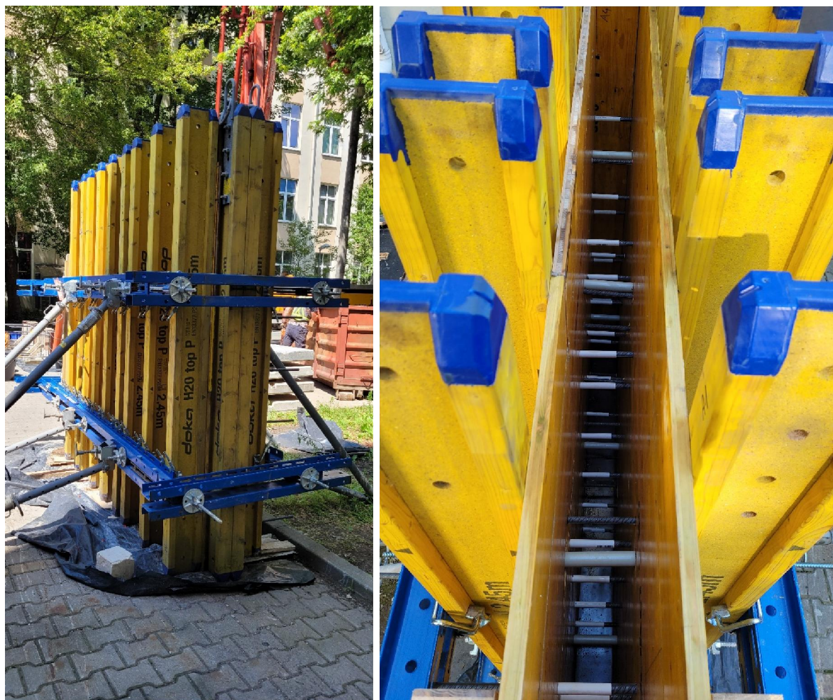
Rys. 4.7. Przygotowane deskowanie dla elementu badawczego typu ściana
