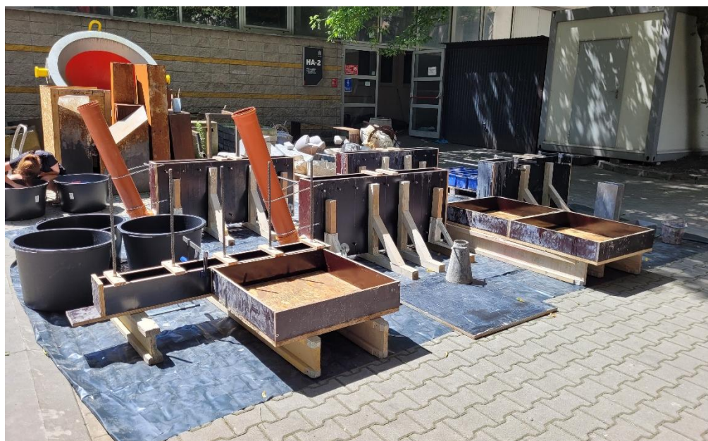
Rys. 4.8. Przygotowane formy dla elementów typu belka-ściana i referencyjnego
