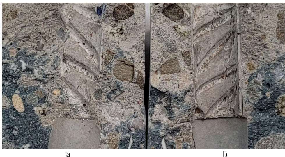
Rys. 6.58. Stan powierzchni betonu po badaniu przyczepności metodą pull-out – pręt dolny elementu TD-W-I10 a) powierzchnia pod prętem, b) powierzchnia nad prętem
