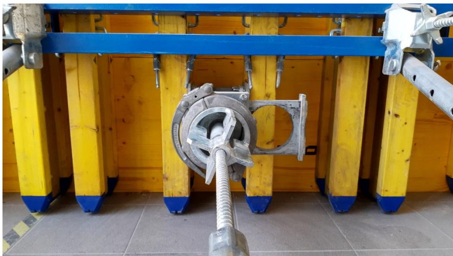
Rys. 2.3. Zawór do pompowania mieszanki od dołu deskowania
