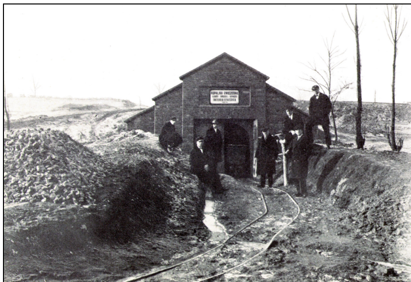
Rys. 1. Zdjęcie wlotu do dąbrowskiej kopalni z okresu jej budowy – 1927 r. (Archiwum Muzeum „Szttygarka”)
