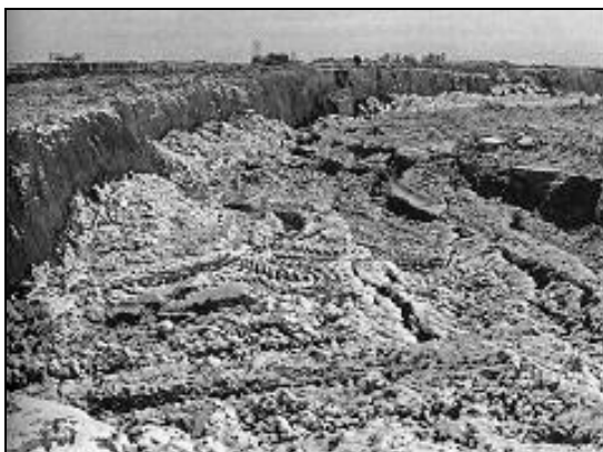
Rys. 17. Osuwisko na zwałowisku zewnętrznym KWB „Turów”
