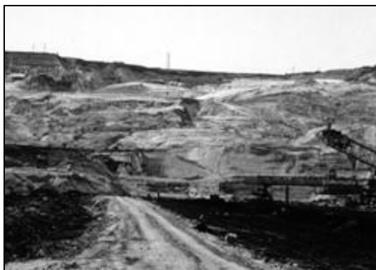
Rys. 16. Osuwisko 20S na południowym zboczu KWB „Bełchatów”
