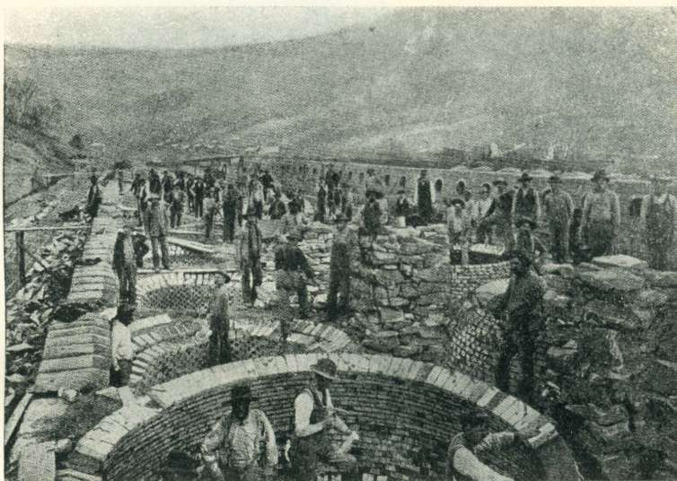
Rys. 80. Widok na baterję pieców ulowych.
