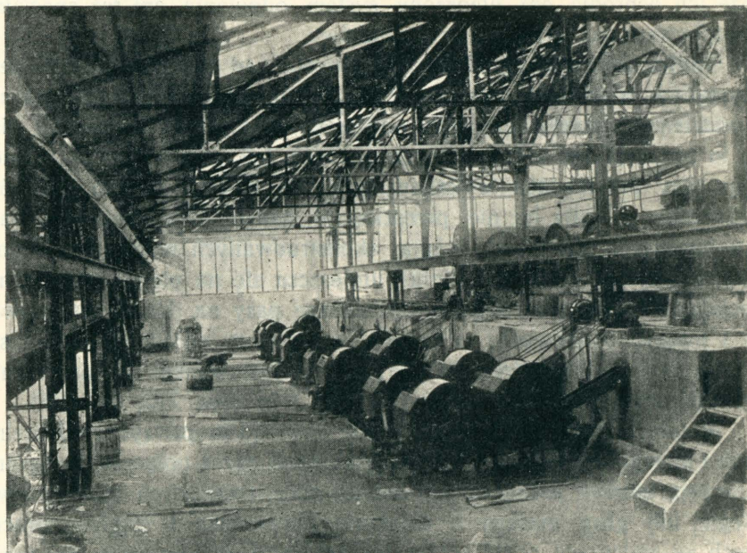
Rys. 249. Widok wewnętrzny zakładu wzbogacania rudy żelaznej sposobem magnetycznym w Süd-Waranger. Rząd podwójnych separatorów Gröndala z oddzielnymi silnikami (w czasie montowania) (II stadium), ustawionych na występie, leżącym poniżej przedstawionego na rys. 248 występu z młynami rurowymi.
