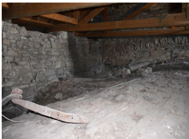
rys. 3. Zniszczone ściągi murów w obrębie sklepienia nawy głównej
