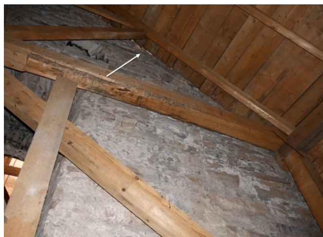
rys. 4. Brak wykończenia blacharskiego na styku połaci dachowej z murem wieży kościelnej
